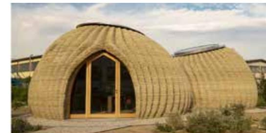
б) напечатанный на 3D-принтере дом из глины, воды, волокон рисовой шелухи
