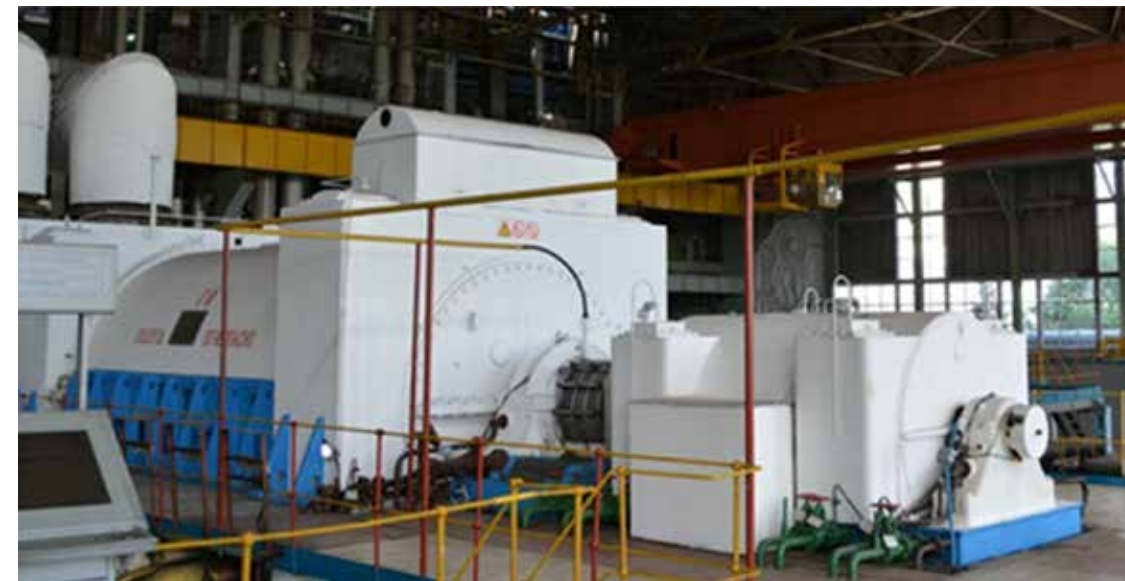
Рис. 1. Турбогенератор ТГ-8 типа ТВВ-320-2
